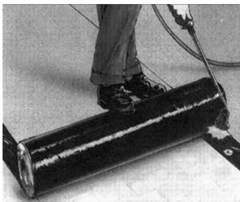
Рисунок 4.1. Разогрев кромок рулонного материала в местах нахлестки пламенем газовой горелки (а) и с прикаткой роликом шириной 100 мм (б).
