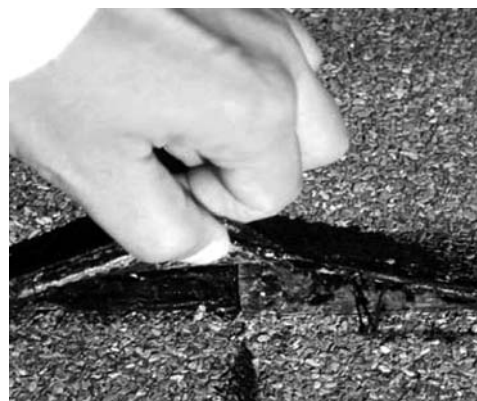
Рисунок 4.9. Дефекты шва (нахлестки) однослойной кровли а) у края шва (неполная проклейка); б) по всей ширине шва (отсутствие проклейки)
