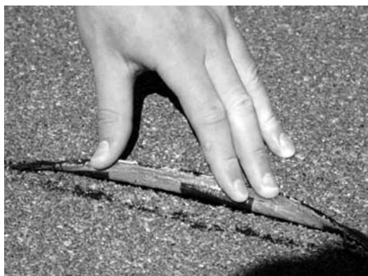
Рисунок 4.9. Дефекты шва (нахлестки) однослойной кровли а) у края шва (неполная проклейка); б) по всей ширине шва (отсутствие проклейки)
